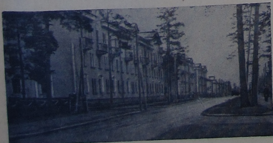
На снимке: Инженерная улица нашего города
