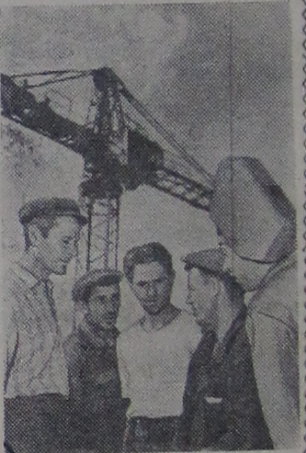
Московские строители участвуют в сооружении жилых домов в Целинограде. Строительный трест Главмостроя решил в этом году соорудить четыре дома на 320 квартир и четыре школы. На снимке (слева направо): монтажники Г. И. Александров, А. О. Евдокимов, А. В. Черников, бригадир А. С. Гучанов и электросварщик В. Н. Клевец. Фото Е. Шулеева. Фотохроника ТАСС
