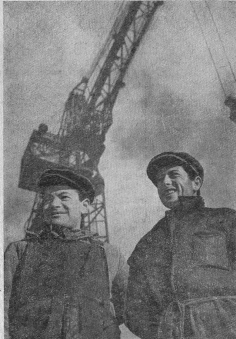
На строительстве гостиницы (институтская часть города) активно трудятся бетонщики комсомолец Варшам ВАРТАНЯН и Юрий ЗАХАРЯН. Фото Ю. Туманова.
