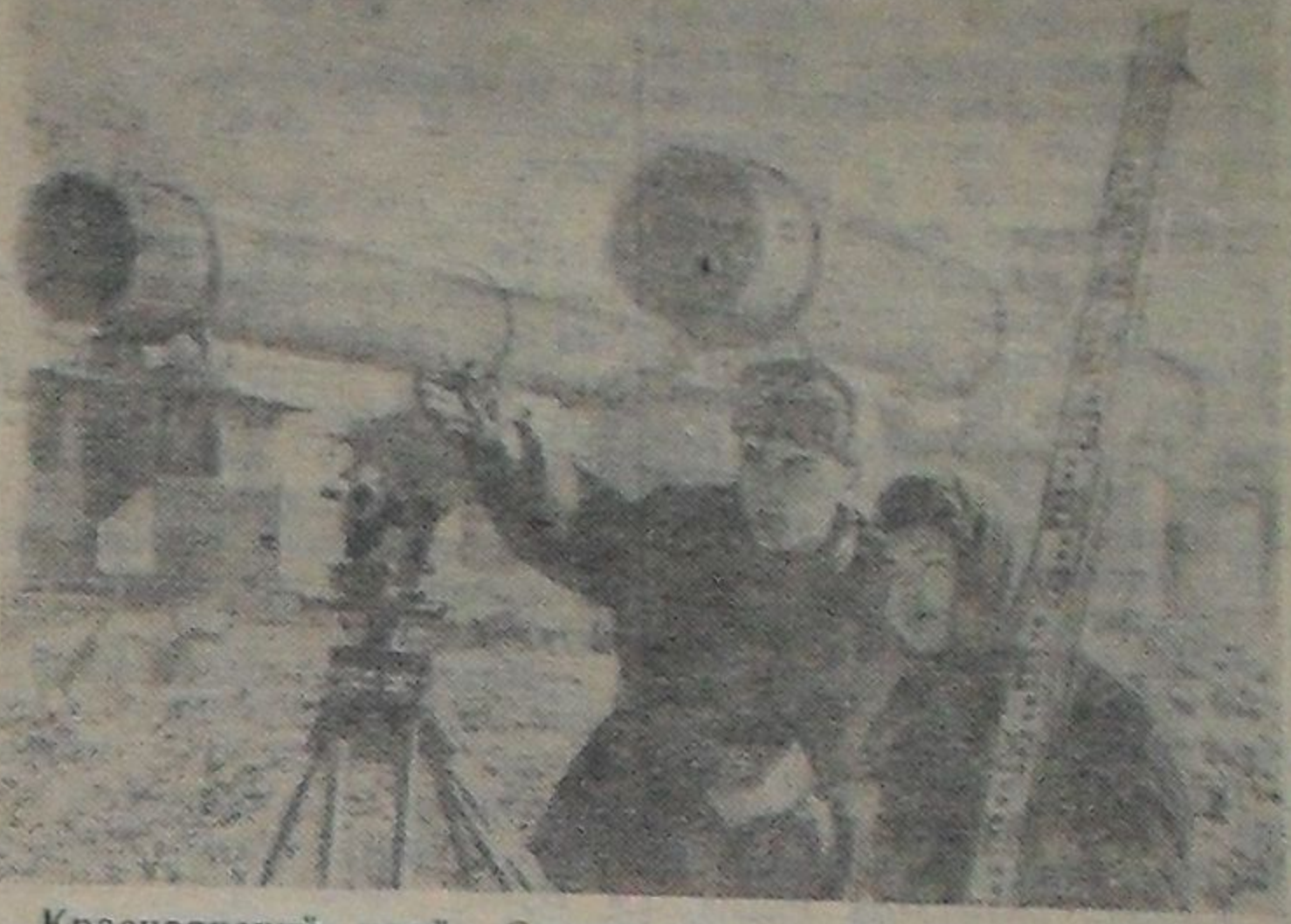
Красноярский край. Строящийся в Ачинске глиноземный завод войдет в комплекс предприятий алюминиевой промышленности совнархоза. Уже в 1963 году намечено сдать в эксплуатацию цементный цех. Здесь установлены две вращающиеся печи по 175 метров длиной. На снимке: геодезисты Н. Д. Евченко и Г. В. Гошевская на «оборудовании цементного цеха. Фото Ю. Бармина. Фотохроника ТАСС
