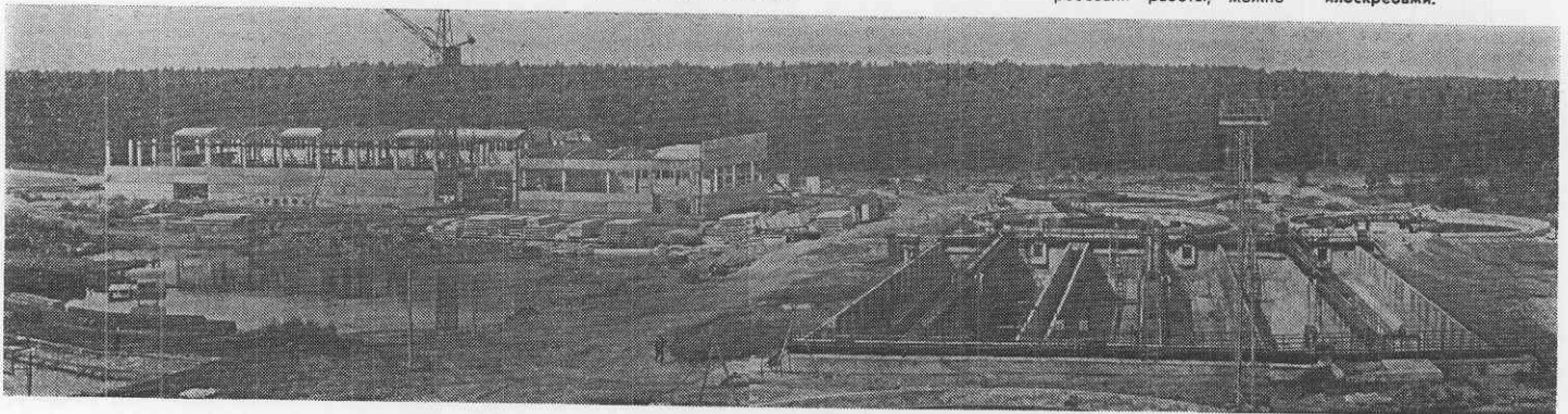
Панорама строительства. Справа — возводится цех доочистки, слева — так выглядит «сухой» аэротенк.
