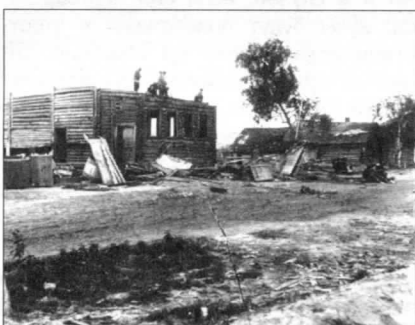
Снос домов в деревне Иваново.
