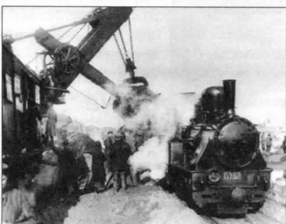
1935 год. Погрузка грунта для дамбы.
