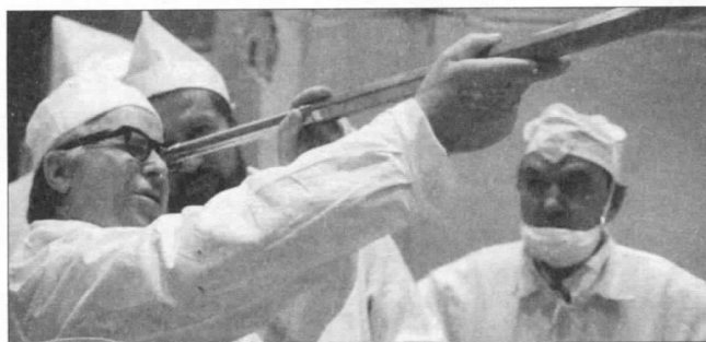
Осмотр кассеты перед загрузкой в зону реактора.
