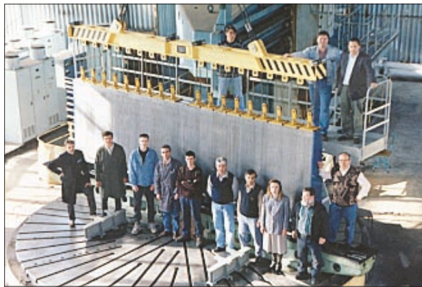
Вот он – «нулевой модуль»! Подсоединена подъемная траверса. Главные исполнители удовлетворены работой.
